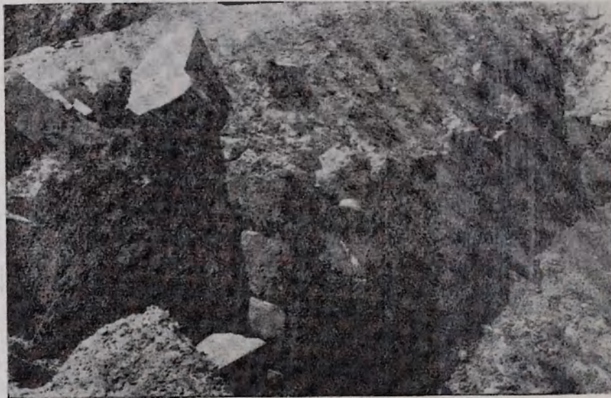
Рис. 21. Фасадная стена северного коридора.
