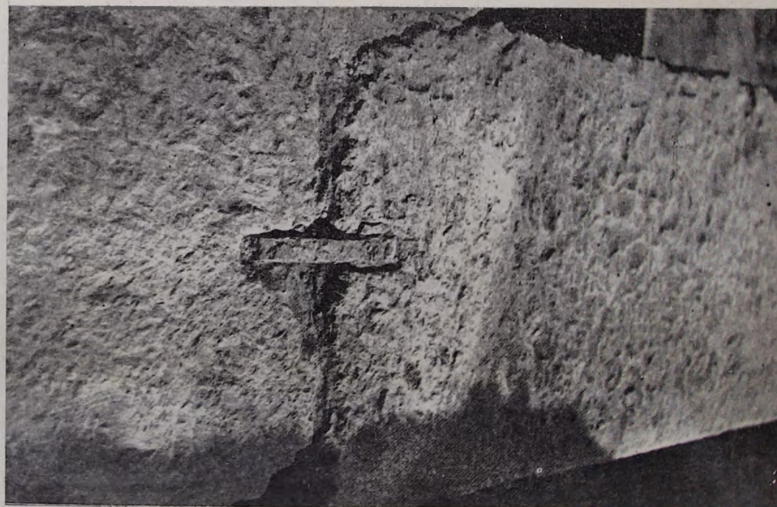
Табл. 18. Скрепление камней железной скобой.
