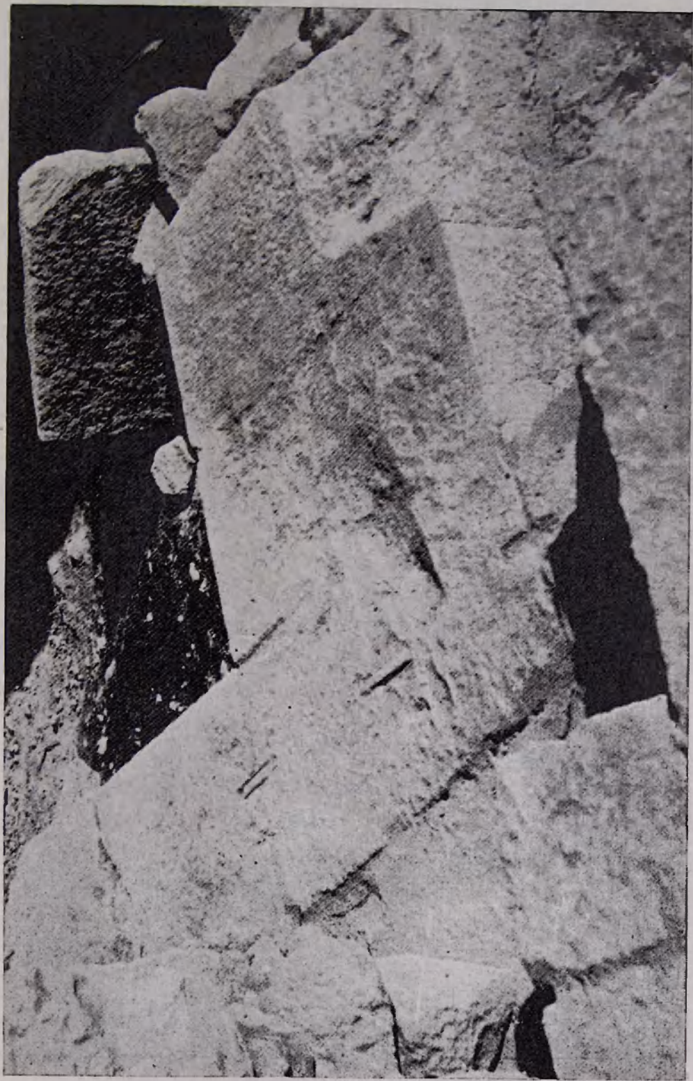
Табл 17. Скрепление камней железными скобами.
