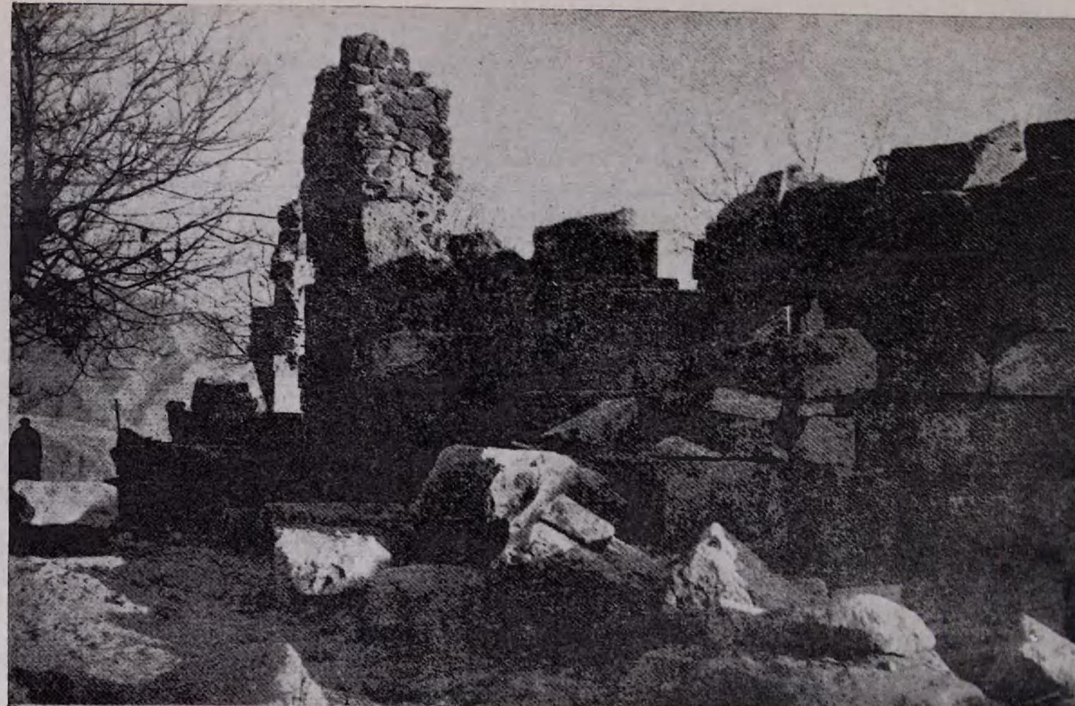
Табл. 13. Северная стена у входа (после раскопок).
