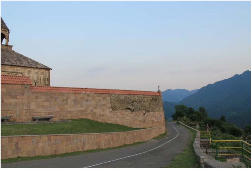
Նկ. 6 Գանձասարի վանքի պարսպից մի հատված՝ երեսապատման գործընթացը դադարեցված վիճակում:
