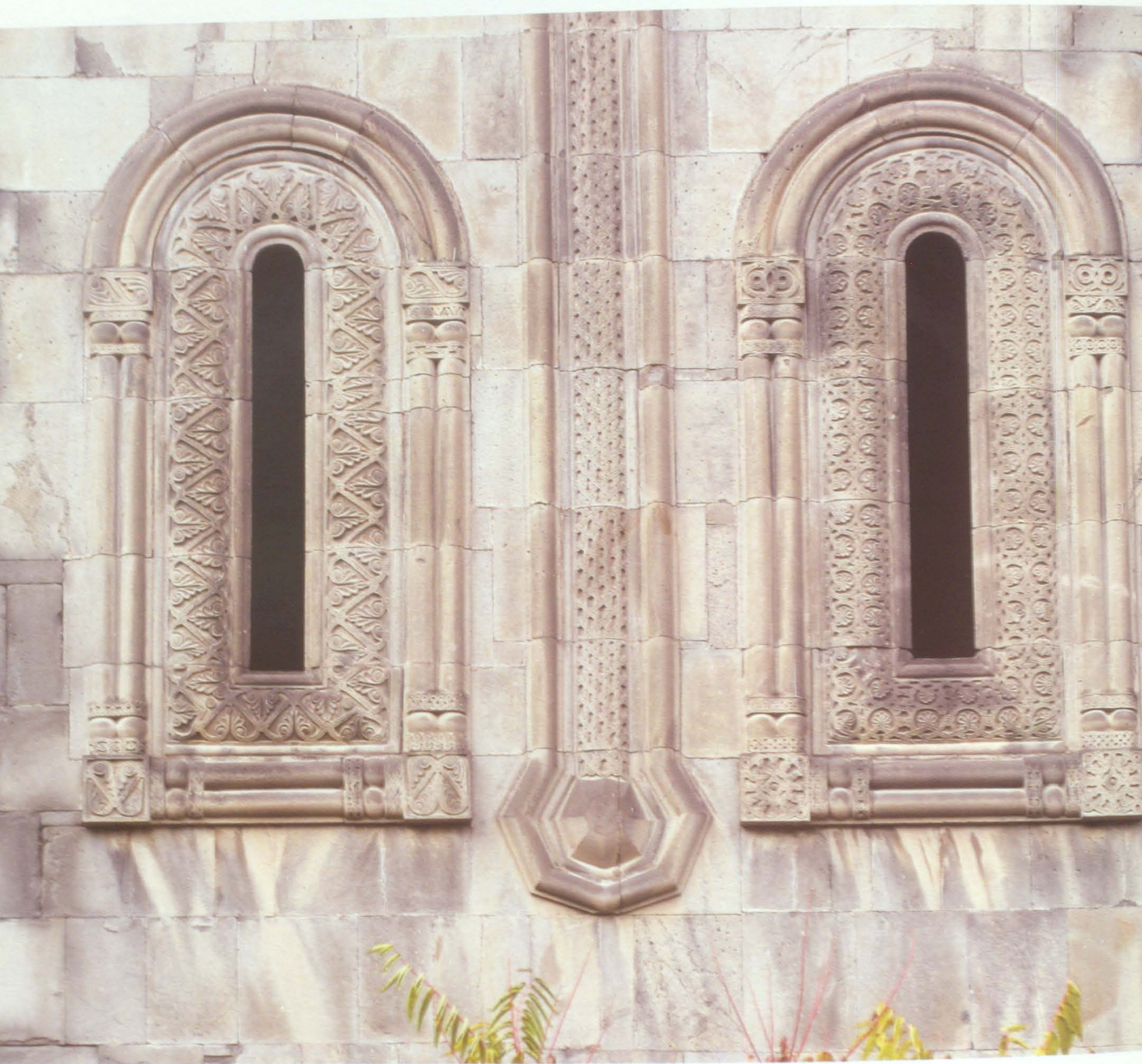
Окна южной стены Windows of the south wall
