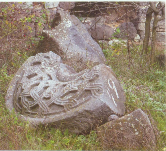
Обломок рухнувшего купола (часть барабана) Fragment of ruined cupola (section of dome)
